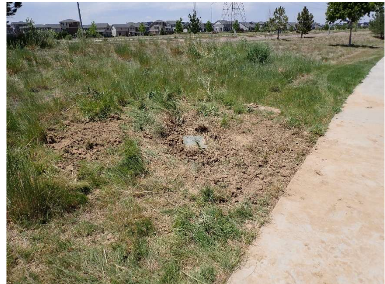
10.) Irrigation box repair
